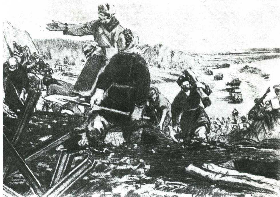
Д. Мочальский. Сооружение оборонительного рубежа под Москвой. Уголь. 1942. 46,5×69.
